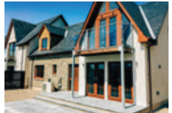
Tower Ridge Courtyard na Škotskem (ZK)
