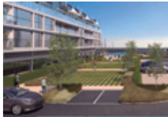
»Marina Village Greystones«: 205 stanovanj in 153 hiš v okrožju Co. Wicklow. (Irska)
