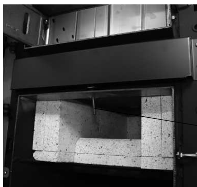
Sl. 70 Očistite tipalo termonadzora (thermocontrol)
