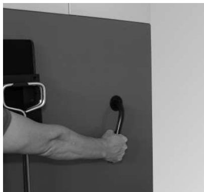
Sl. 50 5–10 x zasučite ročico za čiščenje kurilnih površin
