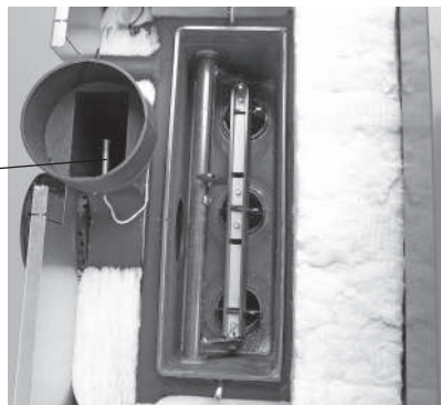
Sl. 71 Očistite zgornje kurilne površine
