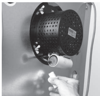
Sl. 67 Izklopite stikalo ventilatorja in odvijte krilne matice
