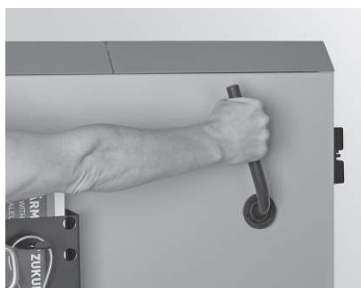
Sl. 50 5–10 x zasučite ročico za čiščenje kurilnih površin
