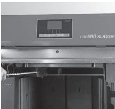
Sl. 65 Očistite dimovod
