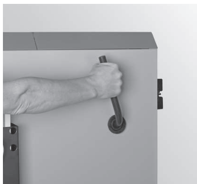
Sl. 61 5 do 10-krat zasučite ročico za čiščenje kurilnih površin
