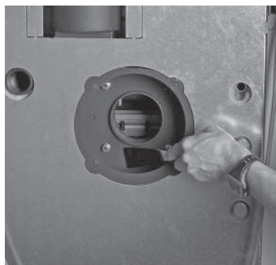
Sl. 69 Očistite notranji prostor ventilatorja
