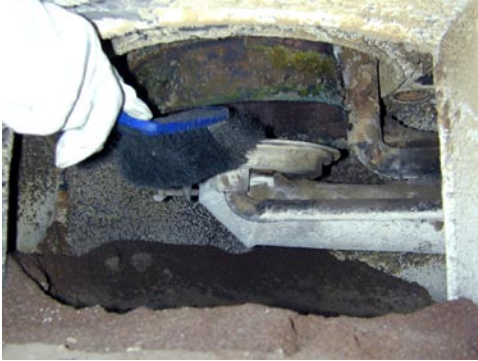
Slika 22: Odstraniti gorilni krožnik
