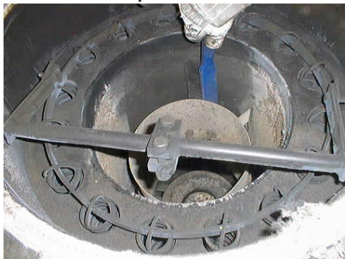
Slika 21: Očistiti stene kurišča
