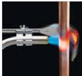
Einsatz mit Flammenreflektor
