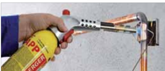
Hartlöten in der Gasinstallation
