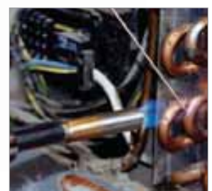
Hartlöten in der Kälte-Klima-Technik
