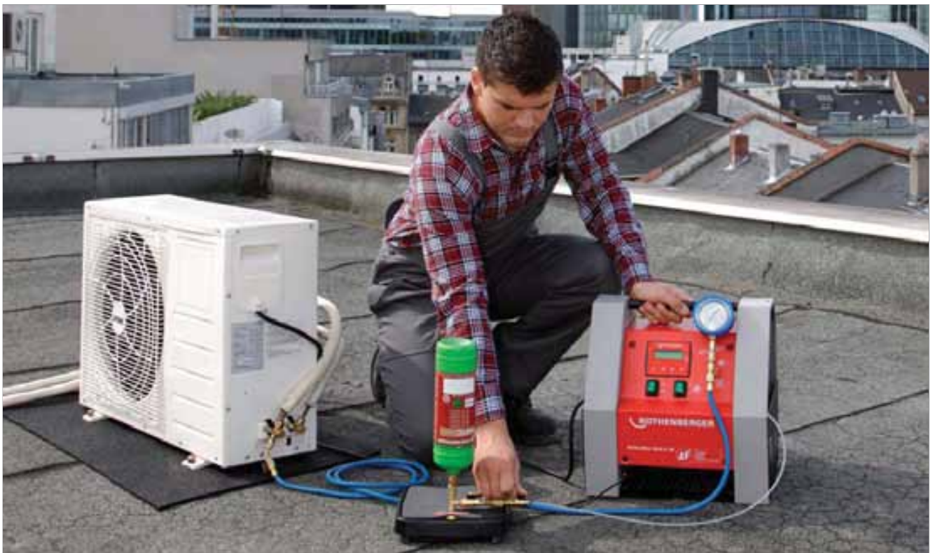
ROKLIMA® MULTI 4F im Einsatz (Evakuieren & Befüllen)
