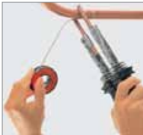
Erwärmung der Lötstelle ohne offene Flamme
