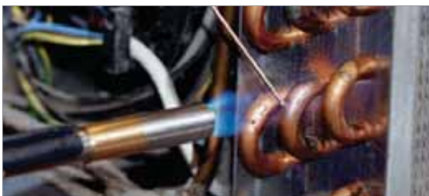
Hartlöten in der Kälte-Klima-Technik
