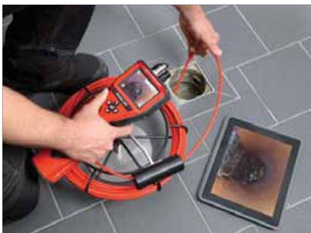
Inspektion von Bodenabläufen
