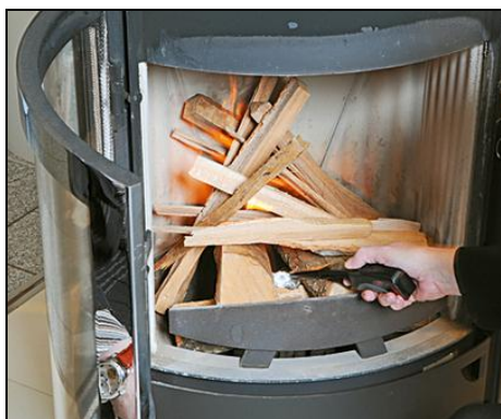
Slika 71; Prižiganje vžigalnega materiala – lesne volne ipd. (Vir: www.heimwerkerlexikon.selbermachen.de )
