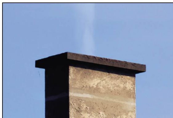
Slika 20; Svetel – neviden dim, razen pare je pokazatelj dobrega zgorevanja, za strokovno presojo so sicer potrebne meritve emisiji
