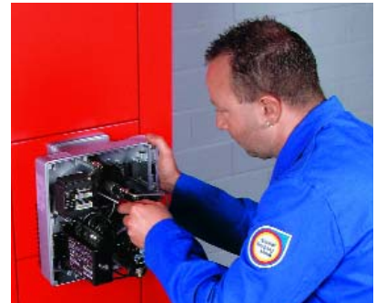
Pregledno nameščene in lahko dostopne komponente poenostavijo servisiranje
