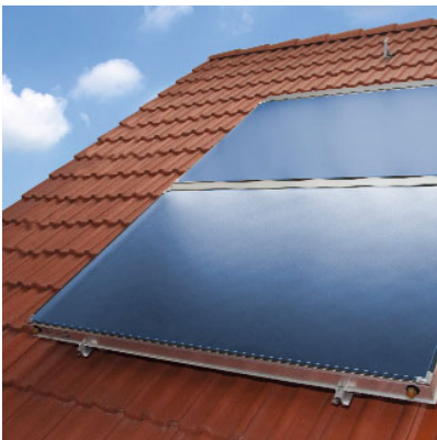
Na strešni konstrukciji
