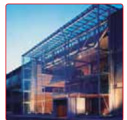
RENEWABLE ENERGIES CENTRE Via Brughiere, 31 località Sazza San Maurizio d'Opaglio (NO)
